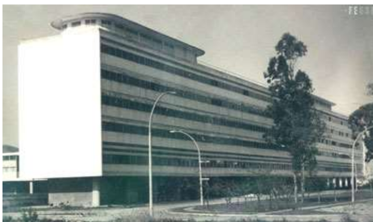
O antigo prédio - http://www2.fe.usp.br/estrutura/cme/curiosidades.html
